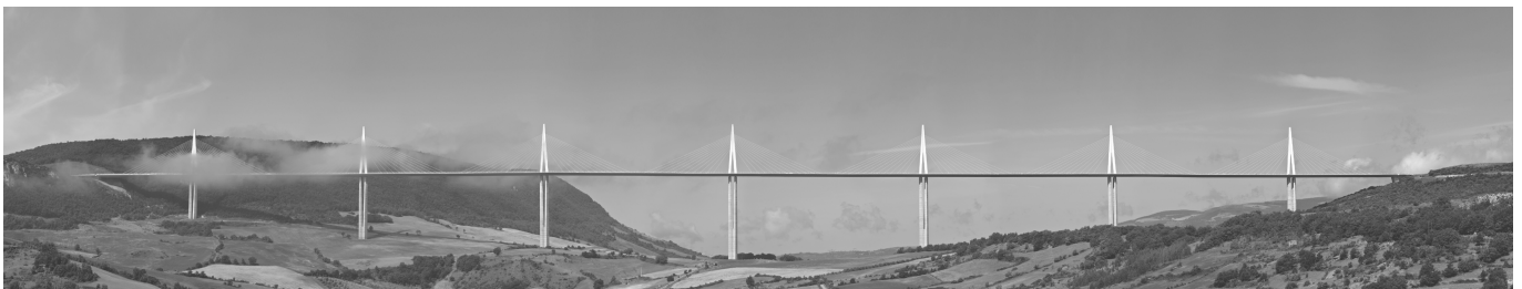
Viaduc de Millau, Südfrankreich, Pylonhöhe 343 m, 7 Pylone, Gesamtlänge 2,46 km
