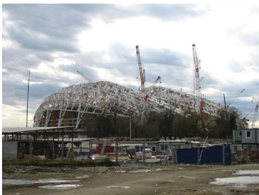
Olympiastadion im Bau (2012)
