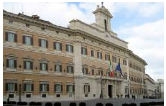
Der Palazzo Montecitorio , Sitz der Abgeordnetenammer (commons.wikimedia.org)
