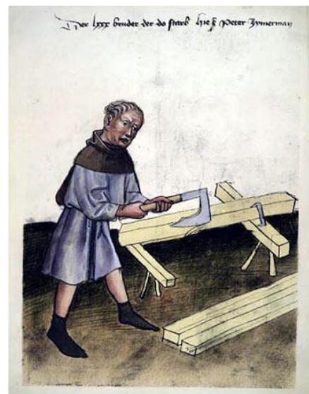
Handwerker bei der Arbeit ( http://www.planet-wissen.de/ 28.07.10)
